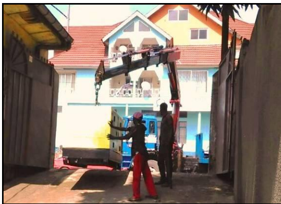
De generator wordt het terrein op gebracht.
